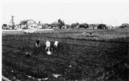
同左調査風景
