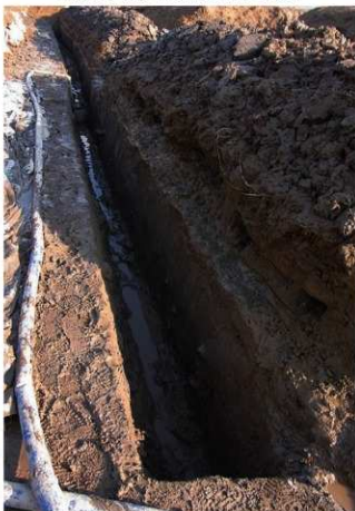
SX01 北側擁壁部分掘削状況
