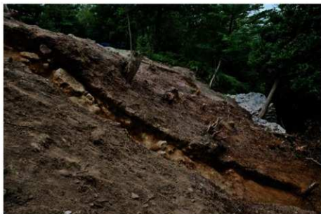
1 H'ライン 南東から
