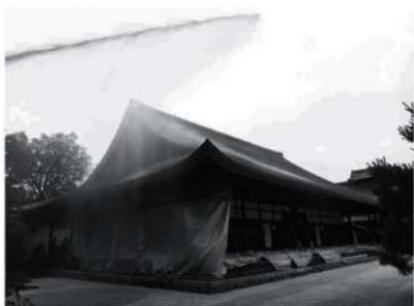
図6 建仁寺方丈 放水銃による放水試験
