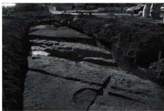
M 2号溝 (東から)
