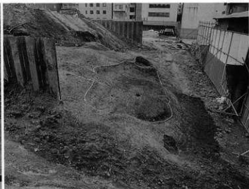
3A-8 トレンチ西部 (北から)
