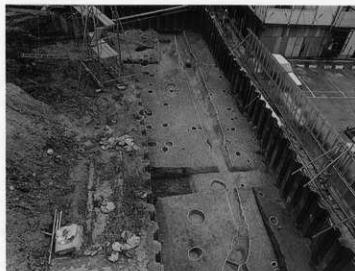
1A-6 トレンチ南部 (北から)
