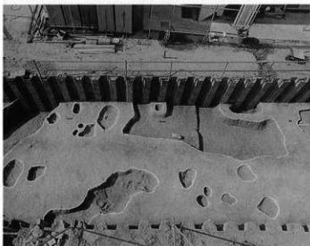
1A-2 トレンチ東部 (南から)
