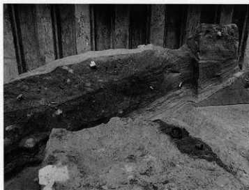
2D-6 トレンチ堀 2 断面 (南から)
