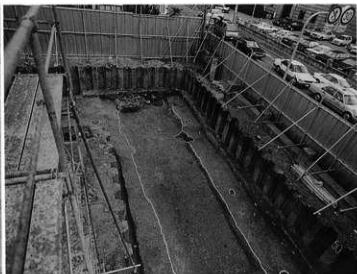
1B-1 トレンチ北部 (東から)
