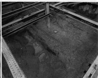
2D-6 トレンチ堀 2 (東から)
