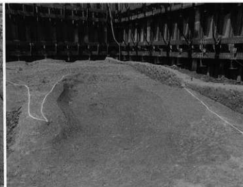
3C-4 トレンチ不定形掘込 (東から)
