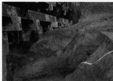
6A-5 トレンチ (東から)
