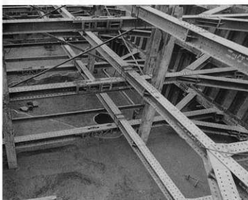
2D-5 トレンチ北部11層上面 (東から)
