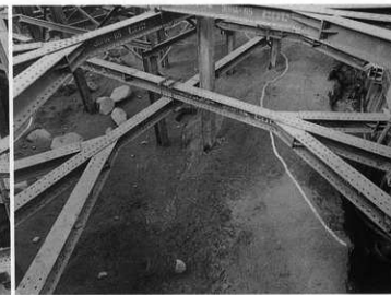
2D-7 トレンチ東部 (南から)
