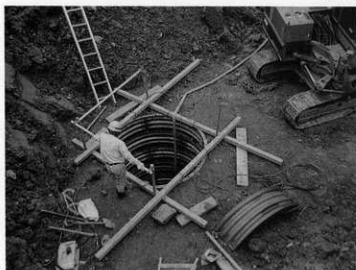
1B調査区深礎掘削作業
