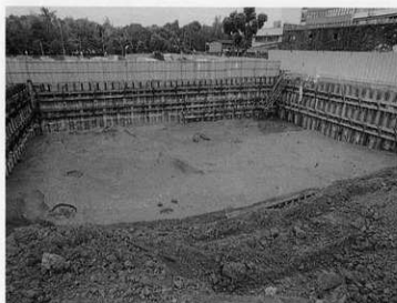
3C-5 トレンチ 11層上面 (西から)
