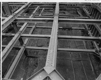
3A-7 トレンチ東部7b層上面 (東から)
