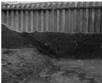
1B-6 トレンチ堀1 断面 (北から)
