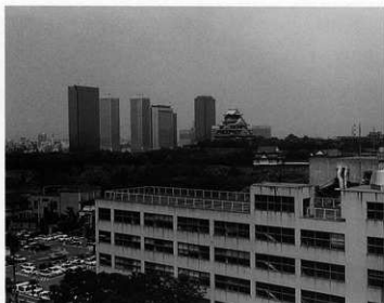
1B、3C調査区（南西から）
