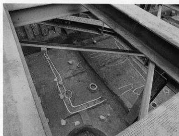
3B-11 トレンチ建物 3
