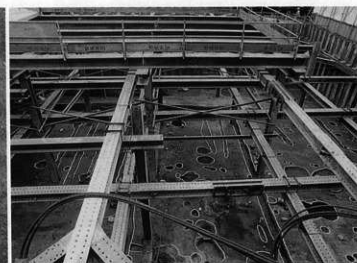
3A-9 トレンチ西部 8b 層 (東から)
