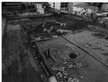
1A-12 トレンチ (東から)
