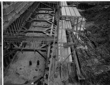
1A-7 トレンチ (東から)
