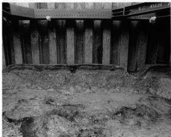
5B-2 トレンチ溝 1・2 断面 (北から)
