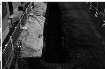
2 区完掘全景 (北東から)
