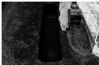
1 区完掘全景 (南西から)
