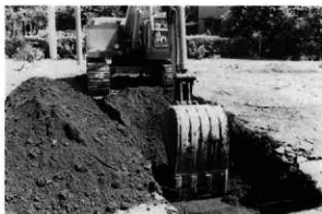
2. 確認調査風景
