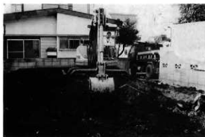
1. 確認調査風景
