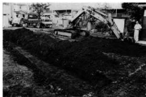
1. 確認調査風景
