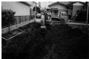
2. 確認調査風景
