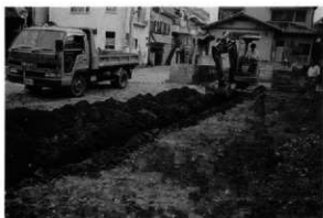
1. 確認調査風景
