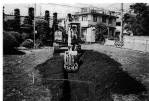
2. 確認調査風景
