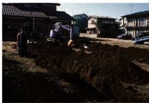
2. 確認調査風景
