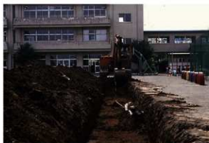
1. 確認調査風景
