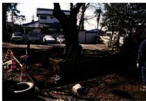
1. 表土剥ぎ風景
