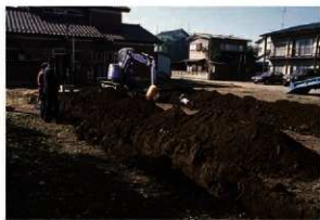
2. 確認調査風景
