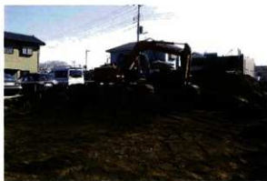
1. 表土剥ぎ風景
