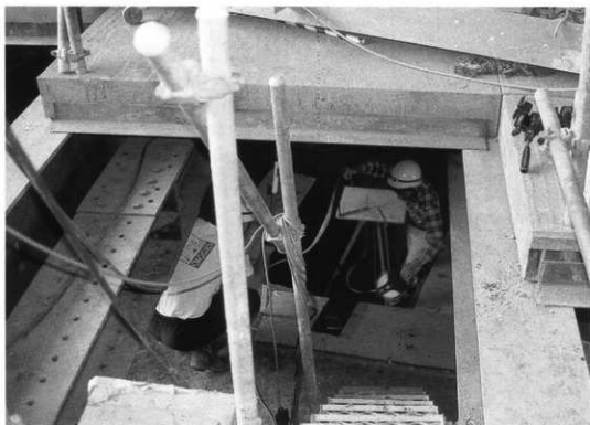
覆工板下作業風景 平板実測（西から）
