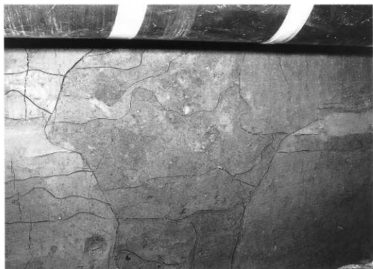
第5区井戸4検出状況（西から）
