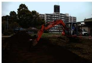
2. 表土剥ぎ風景
