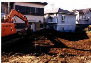
1. 表土剥ぎ風景
