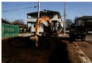
2. 表土剥ぎ風景
