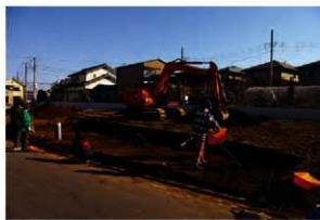
2. 表土剥ぎ及び遺構確認調査風景
