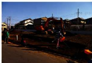
2. 表土剥ぎ及び遺構確認調査風景
