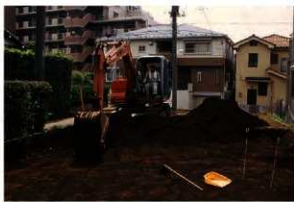
2. 確認調査風景
