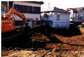
1. 表土剥ぎ風景
