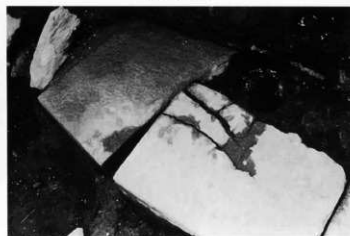
下段基礎設置状況2 (南東コーナー)
