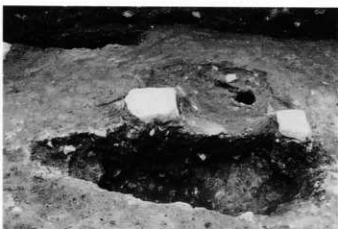
礎石下基礎地溝か (床持柱?)
