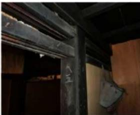
(へ五) の柱 上段の間は、当初の殿居の下に後補の殿居が取り付けられている
