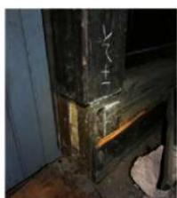
（そ十一）柱 桁の跡がみられる 階段の脇の2階床板太痕
