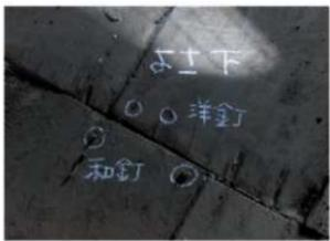
茶の間上部2階吹抜部分の床板、後補の板は洋釘を使用、当初の床板には和釘が使われている
