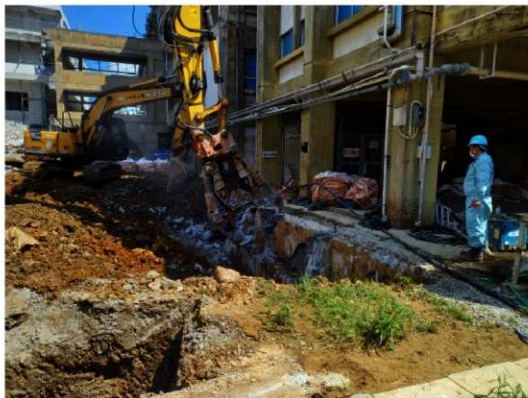
工事立ち会い
