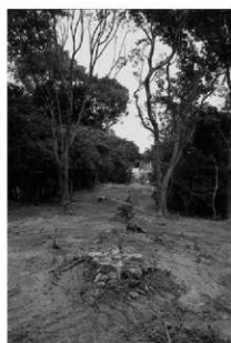
頂部付近埋め戻し状況（西から）
