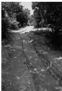
S4トレンチ谷部付近（南東から）
