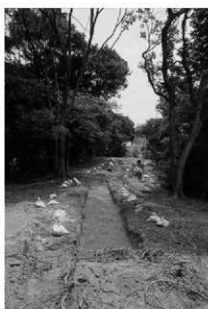
頂部付近調査風景（西から）
