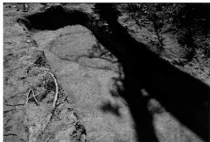
C2トレンチ詳細 (北西から)
