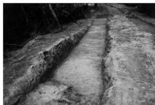
C6トレンチ (東から)
