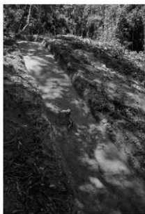
S2トレンチ (南から)
