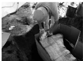
写真7 発泡ウレタンの注入
