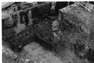
7. 区画5 東側外堀断面(1E 北西から)
