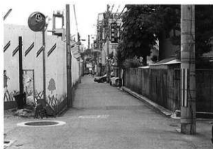
写真4 障壁北門付近 写真左側が調査区(北から)
