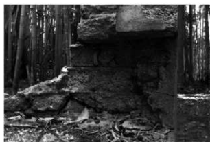
砲跡 煙道部分内面 北西から
