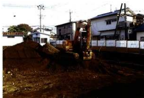
1. 表土剥ぎ風景
