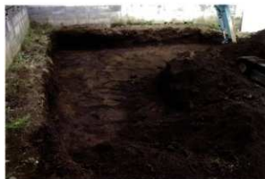
2. 表土剥ぎ作業風景
