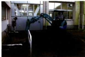
2. 表土剥ぎ風景 (2区)
