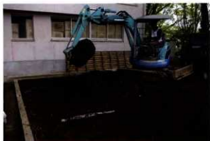
1. 表土剥ぎ風景 (1区)
