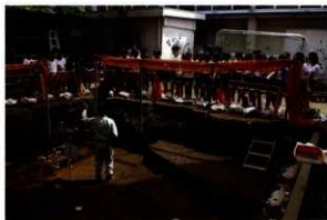
5. 第三小学校生徒現場見学風景
