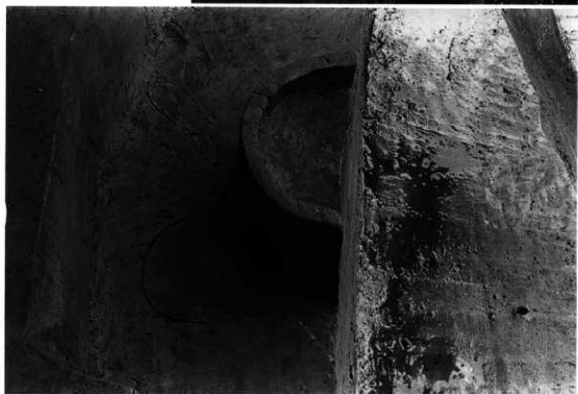
SB1202の柱穴SP1209、地震による水平断層(南から)
