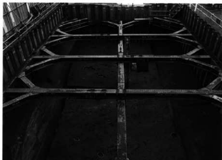
第12層上面 検出状況 (西から)
