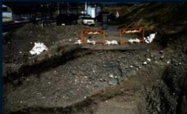
将監堤断面：砂礫とシルトを交互に積み上げている構造がわかる
