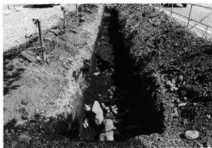
4. E トレンチ全景
