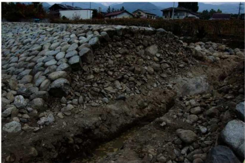
堤防の断面構造
