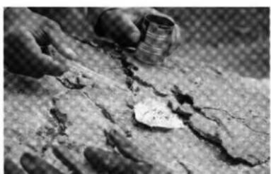
写2-4-21 バラロイド溶液を浸透させている状況
