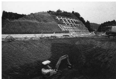
挿入図版1 掘削面にみる深層基礎
