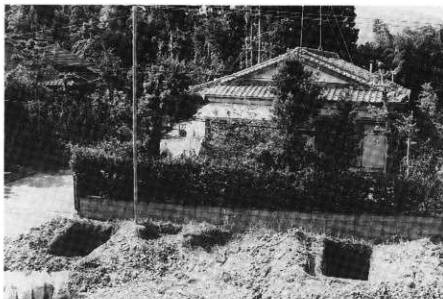
B地点 トレンチ配置状況 左から1・2・3ト レンチ
