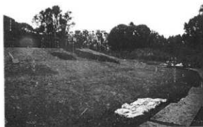
後門部東側填丘形態を修復した状態
