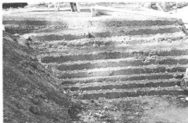
施工者が二社のため同一工種が途中で代わる場合段処理し、盛土の一体化を図っている
