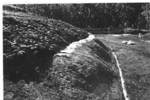
続いてローム土で版築盛土
