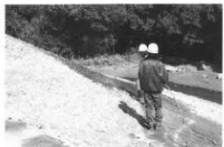
葺石養生(ニガリ水散布-2~3日間隔で実施)
