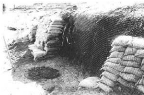
損傷を受け崩壊した部分の養生
