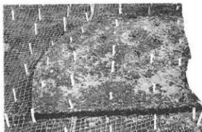
保護モルタルの仕上げ部分
