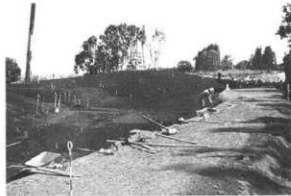
法面は削り落とした後再度平板で敷き締めた
