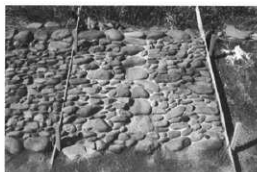
葺石の試験施工(水平ラインが強調され現代的な葺石—小端積的)
