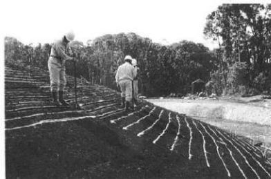
保護盛土の一層目には二層目とのずれを防ぐために小段をつけた
