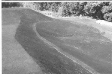
平成 18 年度竣工状況 (填丘東側)
