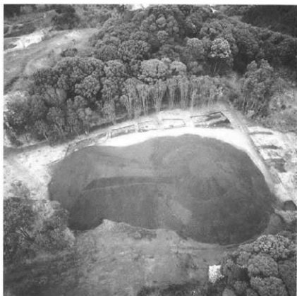
平成 18 年度竣工状況（東より）
