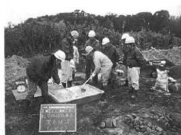
塩化マグネシウム(ニガリ)混合状況
