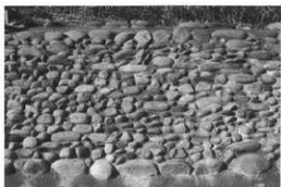
葺石の試験施工(水平ラインが強調され現代的な葺石—小端積的)
