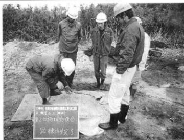
踏練り完了 (手で握って団子状に固まって形が崩れない程度)
