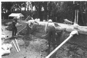
版築上に盛上し余分な部分を削り落し角度を再現した
