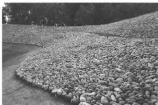
平成 19 年度竣工状況(後円部)
