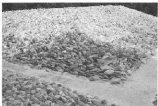
平成 19 年度竣工状況(前方形隅角)
