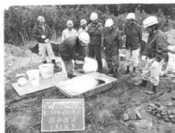
消石灰混合状況
