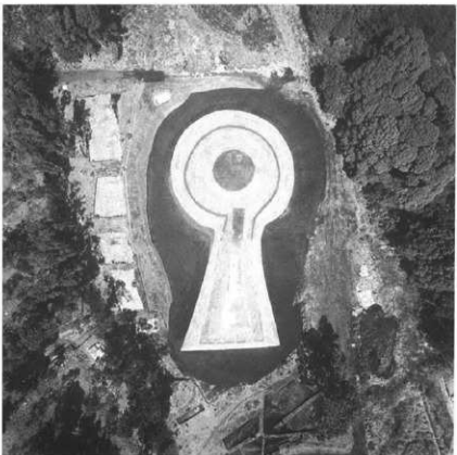
平成 19 年度竣工状況(上空より)
