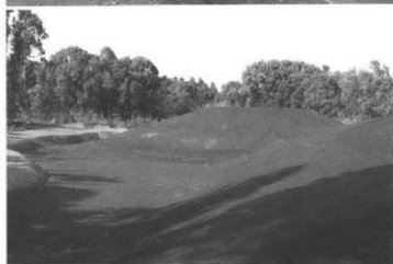
平成 18 年度竣工状況 (周溝部)
