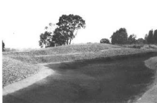
平成 19 年度竣工状況(周溝部北西より)
