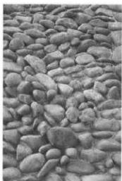
試験施工最終形態—自然な石の配置と組み合わせ
