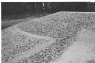
平成 19 年度竣工状況(墳丘上より)
