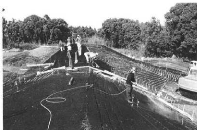
保護盛土は乾燥を防ぐために過度の散水をしている
