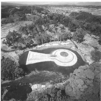
平成 19 年度竣工状況（東より）
