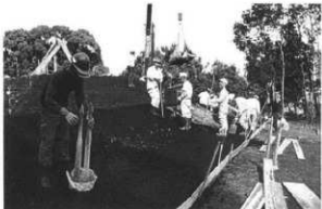
保護盛土は一層 10cm の仕上げで二層 20cm の厚さに仕上げた
