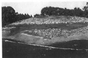
後門部西側填丘形態を修復した状態
