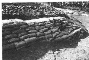
崩壊部分は崩石への影響を配慮し土糞で盛土
