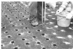
平成18年度仕上げ地盤への削杭(三和土敷き仕上げと既設地盤の馴染を図る)
