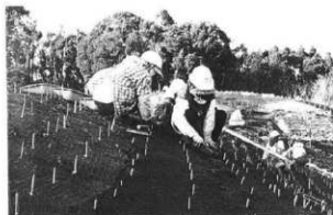
保護ネット上に仕上げ厚5cmで保護モルタルを仮しく叩き占めた
