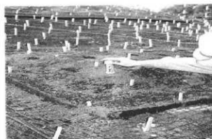
保護モルタルの強度と施工の品質を硬度計で確認しながら施工
