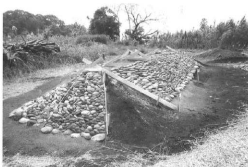
葺石工の試験施工
