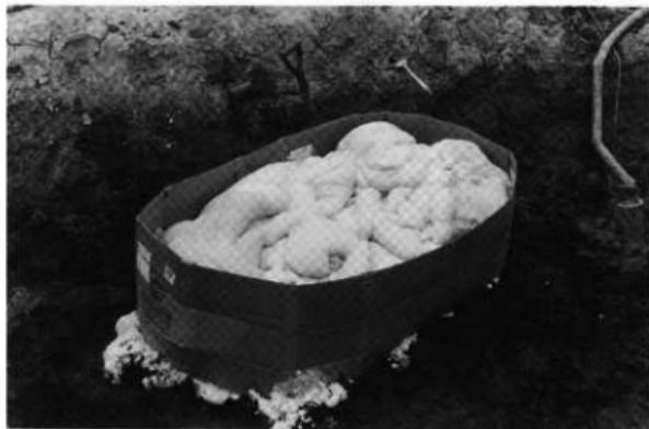
ウレタン液を枠の中に隙間なく充填する
