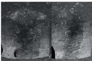
SA 14-P 1、2断ち割り状況
