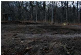
5. 埋め戻し状況 (東から)
