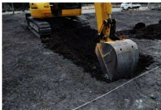
3. 掘削状況 (北西から)
