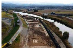
調査地遠景 下流側（西南）から望む
