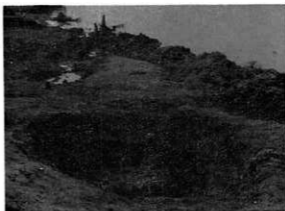
No.11 D3区杭列に隣接してあらわれた第1号井戸
