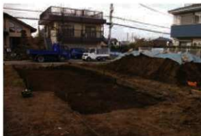
3. ②地点表土剥ぎ後風景
