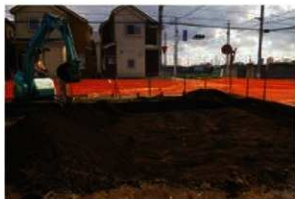
4. ③④地点表土剥ぎ風景
