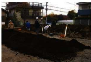
2. 確認調査風景
