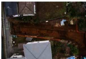
1. 4区全景（南より）
