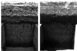
4. 1号試掘坑断面
