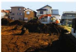
4. 表土剥ぎ風景 (第62-2地点)
