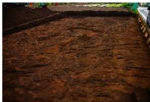
3. 表土剥ぎ後風景
