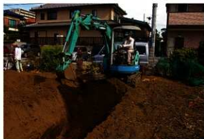
2. 確認調査風景
