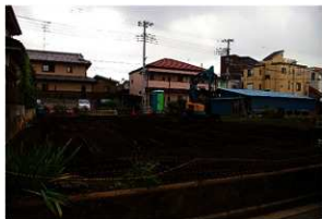
8. 埋め戻し作業風景
