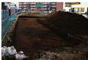
3. 表土剥ぎ後調査区近景
