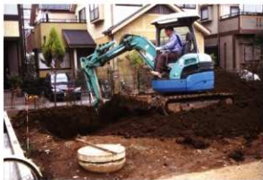
2. 表土剥ぎ風景
