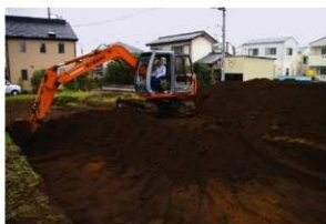
2. 表土剥ぎ風景
