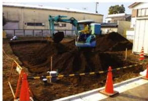
2. 表土剥ぎ風景
