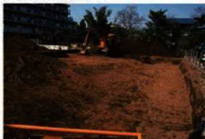
1. 表土剥ぎ風景
